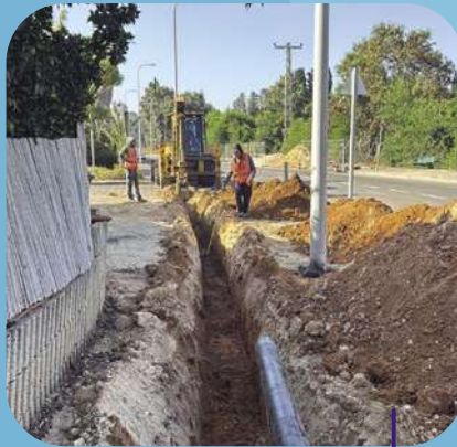
↓ רחוב שפק שדרוג קו מים בקוטר 6"
