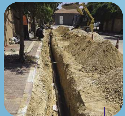
↓ רחוב שועלי שמשון שדרוג קו מים בקוטר 8"
