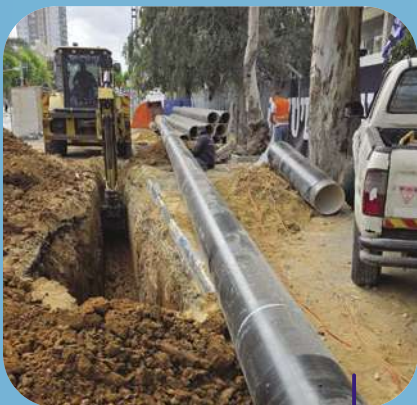
↓ רחוב הרברט סמואל הנחת קו מים בקוטר 16"
